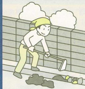
側溝にごみや落ち葉、木の枝などが詰まっていると、水が流れずあふれ出し、冠水の原因になります。1カ所の詰まりが周囲の冠水を引き起こし、自分の家の周りだけでなく、地域全体に大きな被害をもたらします。
