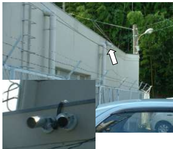
給水塔に設置された監視カメラ。
