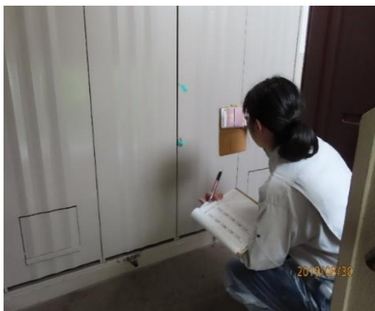
塗装剥がれ点検補
