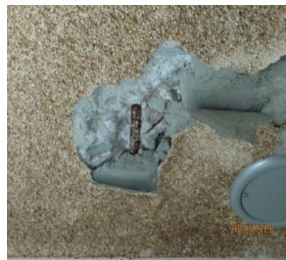
天井爆裂部補修
